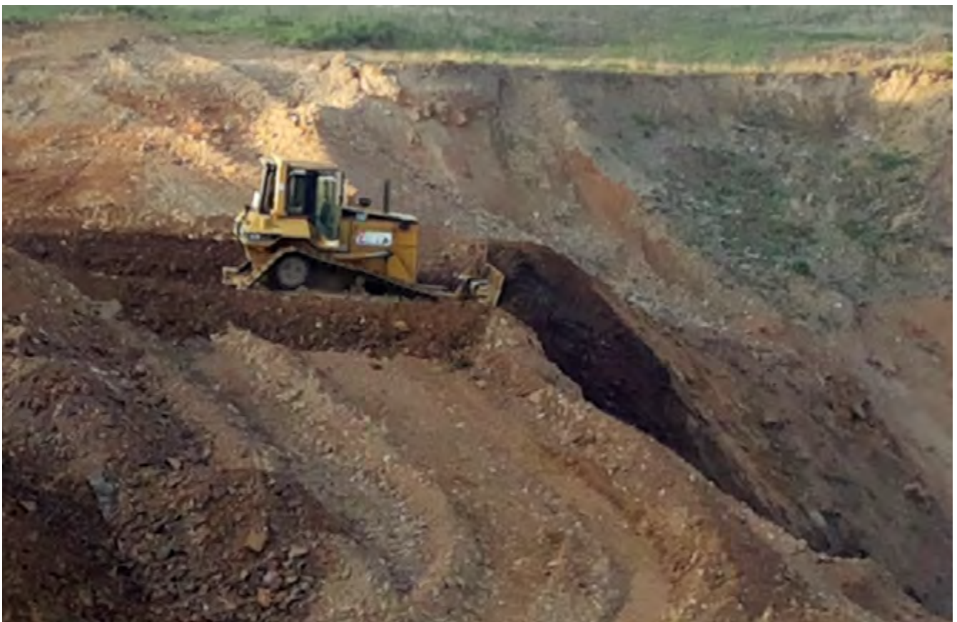
Abb. 1 Abschieben des abgekippten Materials mit einer Raupe
