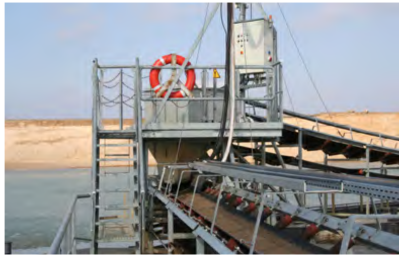
Abb. 1 Sichere Verkehrswege auf schwimmendem Gerät
