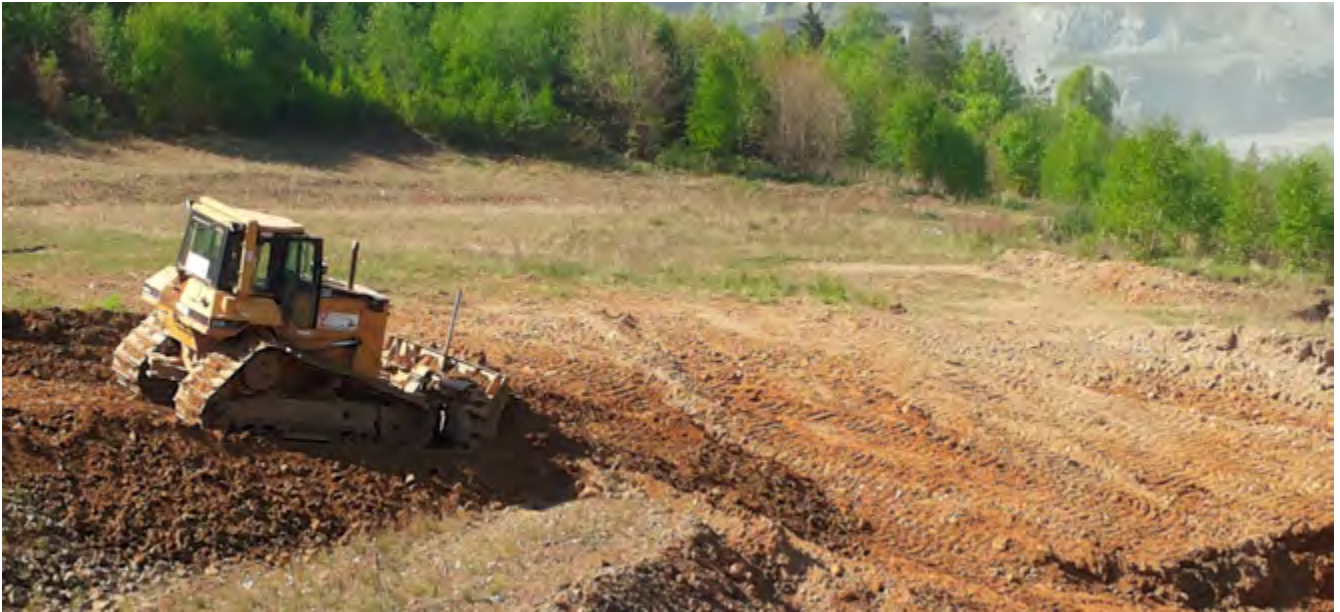
Abb. 1 Regelkonformes Abschieben von Abraum mit einer Raupe
