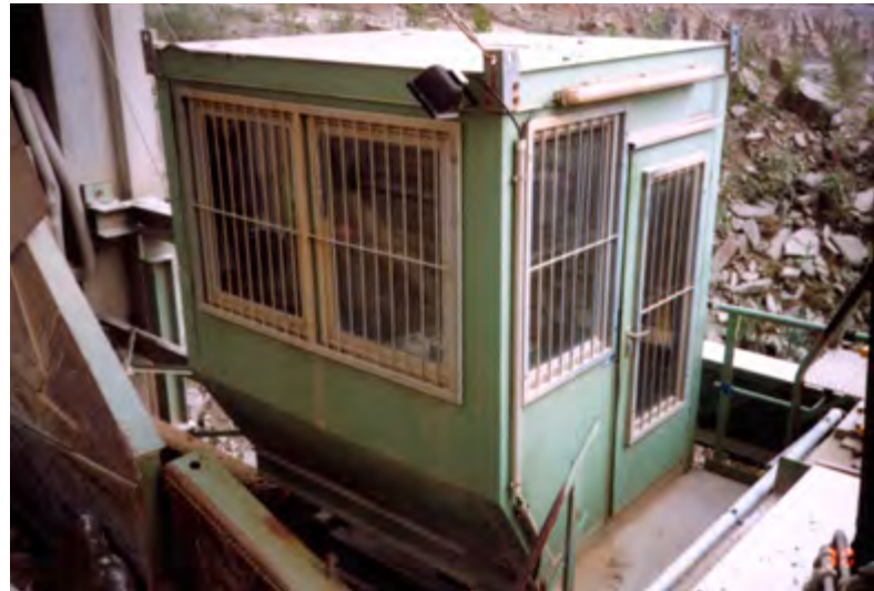
Abb. 1 Brecherkabine schützt vor Lärm, Staub und Steinflug
