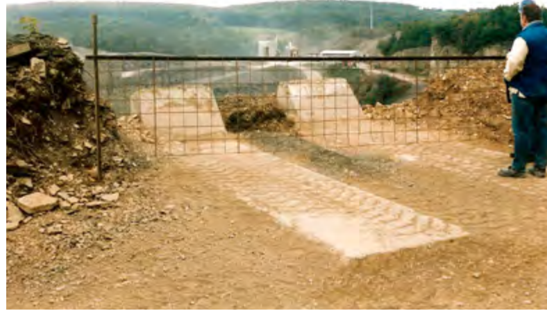
Abb. 2 Stationäre Abkippstelle mit festen Anschlägen
