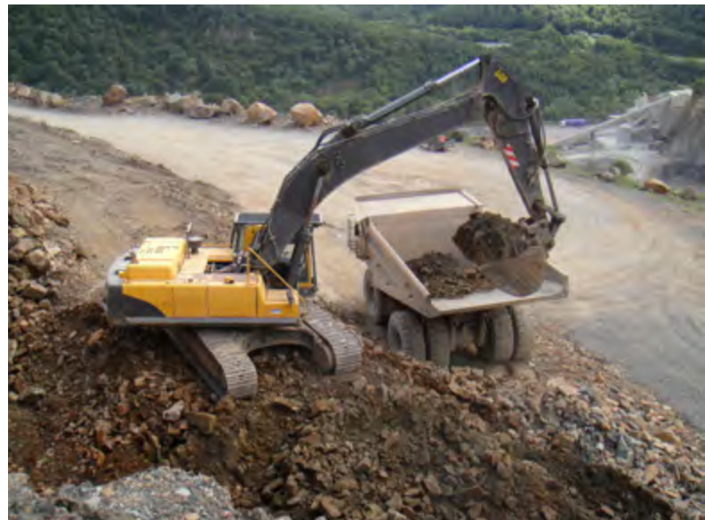
Abb. 2 Beladen mit einem Tieflöffelbagger von der erhöhten Arbeitsfläche
