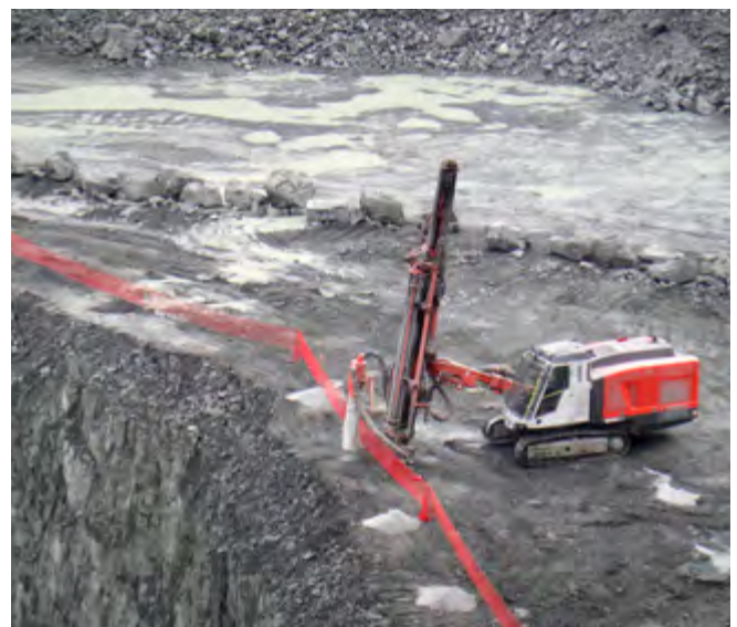
Abb. 3 Herstellung der Wandneigung durch Bohrarbeiten
