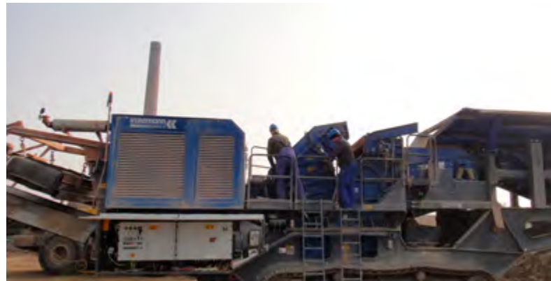
Abb. 2 Mobile Brecheranlage mit Raupenfahrwerk bei der Reparatur
