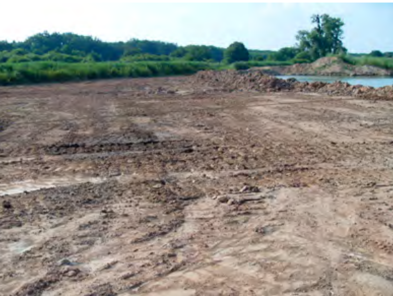
Abb. 1 Abraumbeseitigung für die Kiesgewinnung
