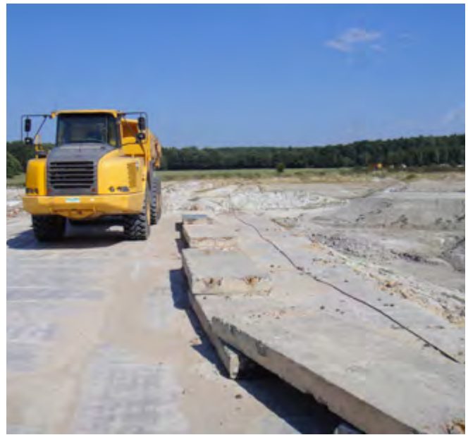
Abb. 2 Mit Betonplatten befestigte Fahrstraßen
