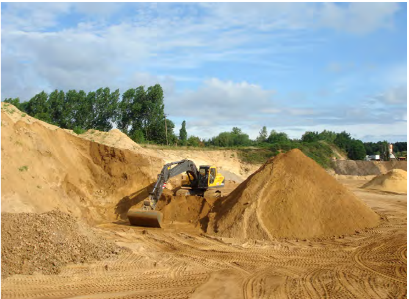
Abb. 2 Gewinnung im Tiefschnitt mit einem Hydraulikbagger
