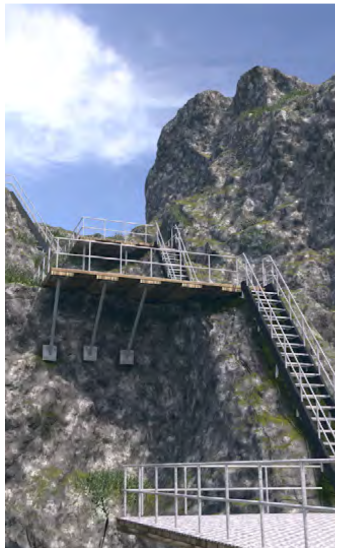
Abb. 2 Sichere Verkehrswege in Werksteinbrüchen
