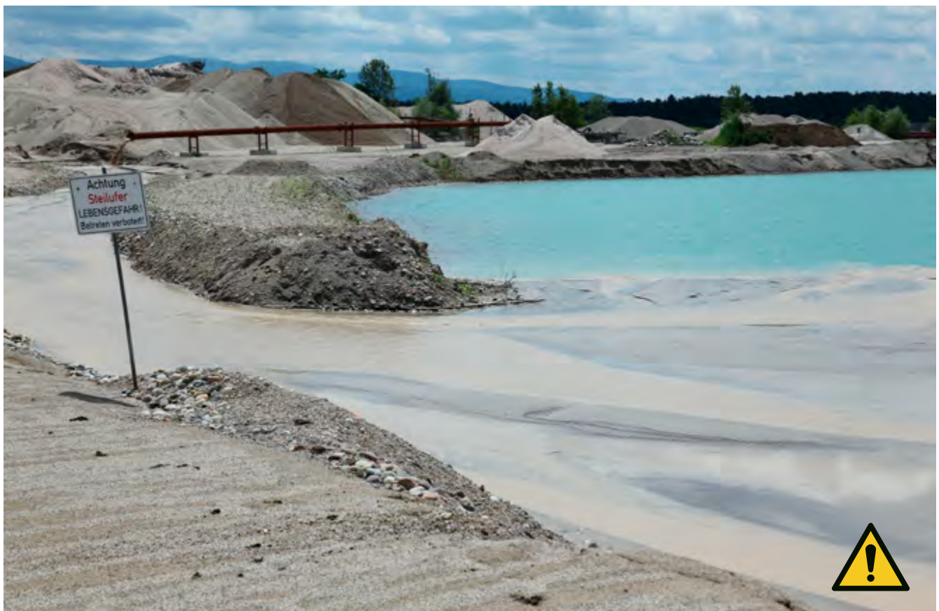
Abb. 1 Absetzteich mit der Gefahr des Einsinkens
