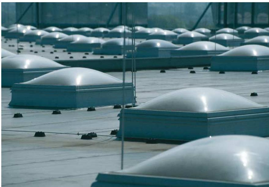
**Bild 8:** Lichtkuppeln zur Beleuchtung einer Halle.
