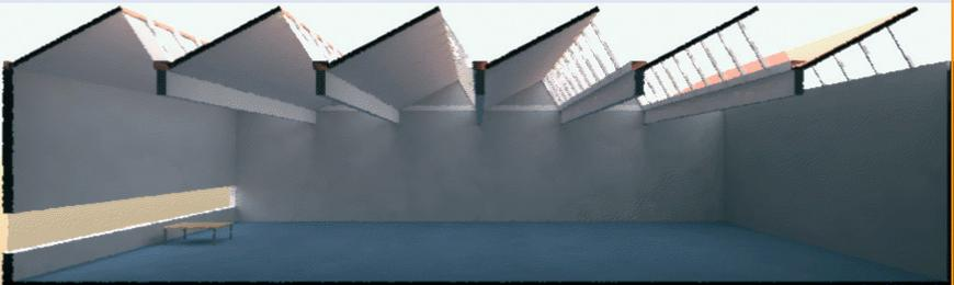
Durch das Sheddach ist der Tageslichteinfall hoch. Die Halle erhält das diffuse Himmelslicht aus Norden, das nicht blendet. Das Licht fällt zum einen Teil direkt in den Raum. Zum anderen Teil wird das Licht an die lichtundurchlässigen Deckenbereiche gestrahlt und hellt sie auf. Von dort aus wird das Tageslicht in die Halle reflektiert.
