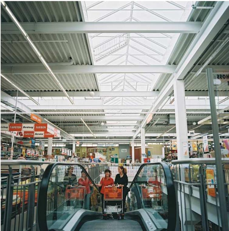
**Bild 9:** Beleuchtung mit Lichtband
