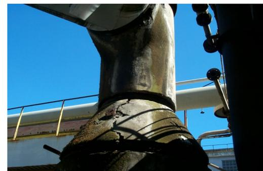
*apparecchiatura coibentata con cemento amianto*
