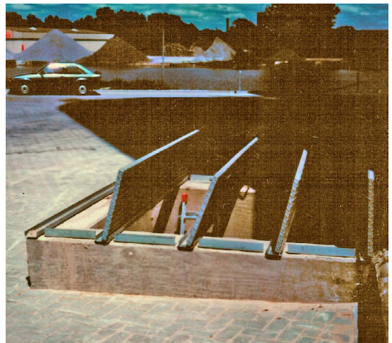
Bild 38: Notausstieg aus einem Silokeller, der gleichzeitig als Druckentlastung dient.
