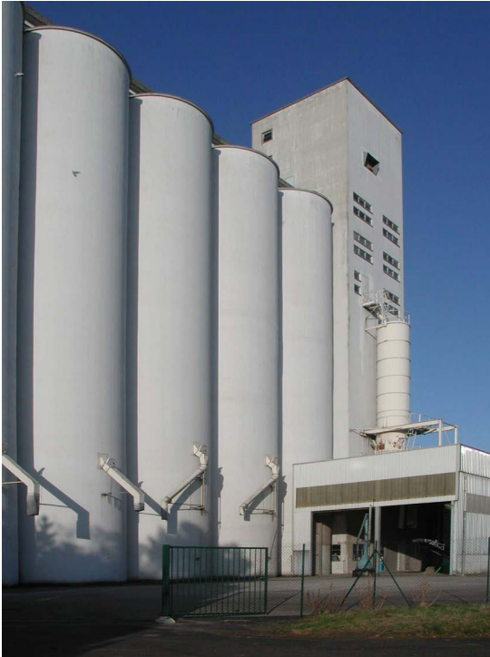
Bild 37: Silos mit Maschinengebäude und Druckentlastungsflächen
