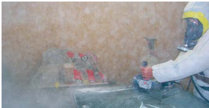
Fresatura di serpentinite senza aspirazione alla fonte
