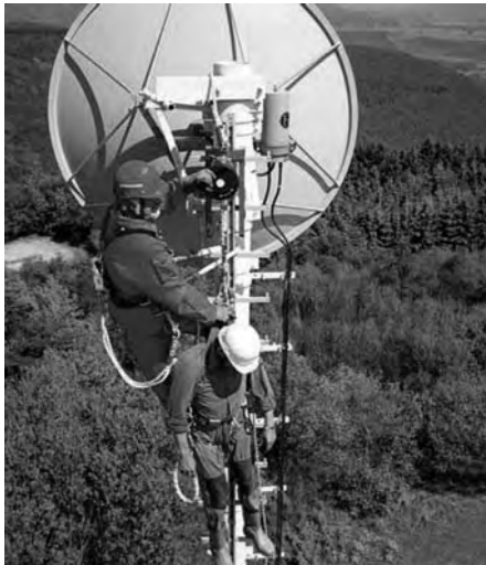
Bild 19: Beispiel 1 – Rettung einer abgestürzten Person
