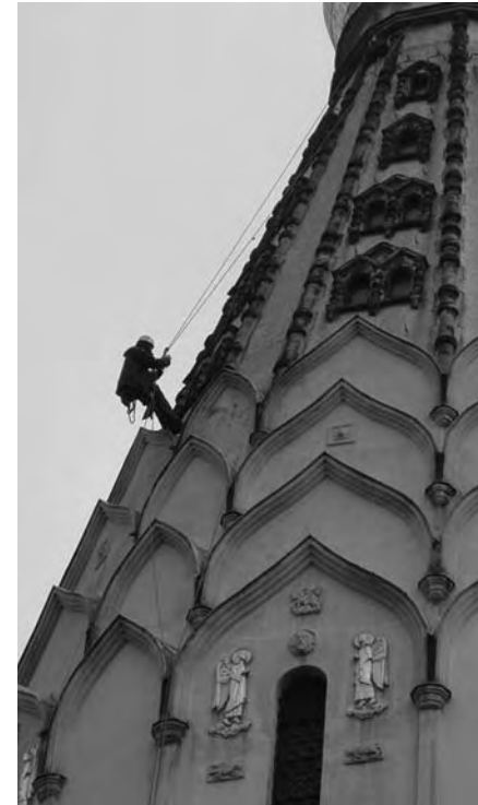
Bild 7: Seilunterstützte Arbeits- und Zugangsverfahren
