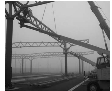
Figura 9: Premontaje a nivel de tierra y montaje con una plataforma elevadora móvil
