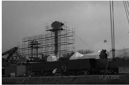
Figura 4: Andamios de trabajo y andamios de protección
