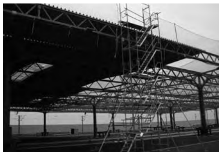
фиг. 12: Стълба при подвижно скеле
