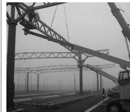
фиг. 8: Монтиране от автовишка на елементи, сглобени на земята
