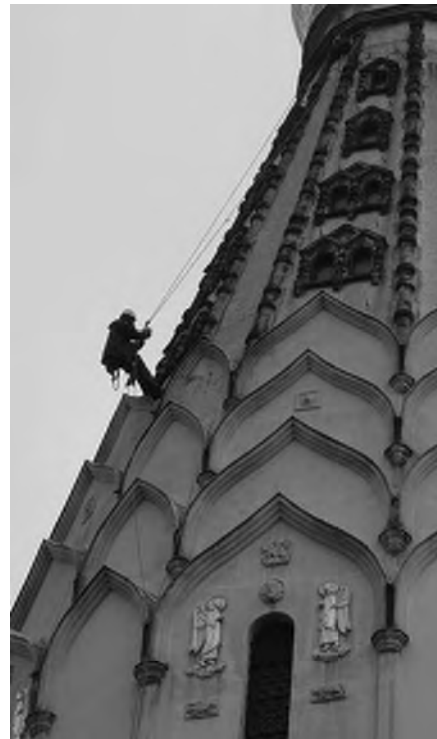
Sl. 7: Radovi kod kojih se koristi tehnika pristupa i pozicioniranja pomoću užeta
