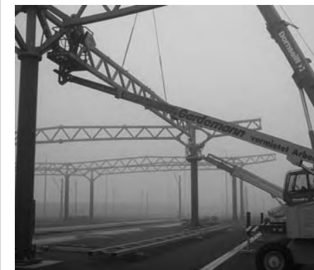
Sl. 9: Sastavljanje komponenti na tlu i postavljanje pomoću platforme za rad na visini
