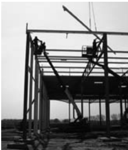
Obr. 5: Pracovní podlahy ve výšce
