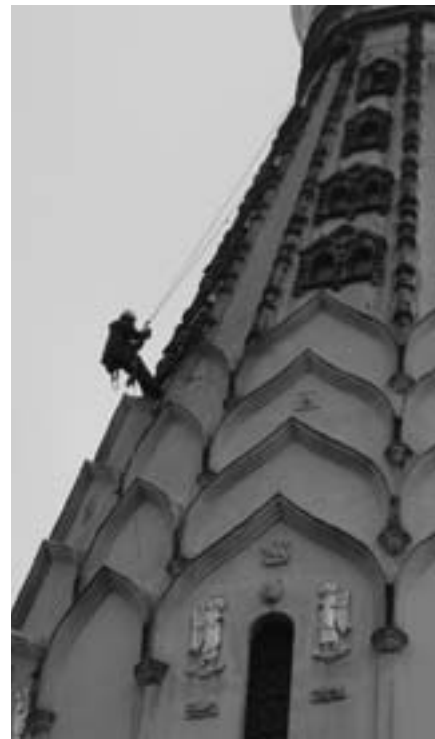
Obr. 7: Výškové práce s využitím lan
