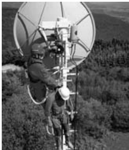
Obr. 19: Příklad záchrany zavěšené osoby
