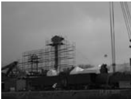
Obr. 4: Pracovní a zabezpečovací konstrukce
