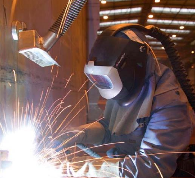
Bild 8 Schweißrauchabsaugung plus Schweißerschutzhaube mit Frischluftversorgung (persönliche Schutzausrüstung)
